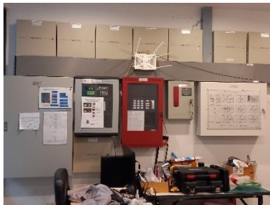
Graphic Annunciator Fire Alarm System และ Fire Alarm Control Panel
